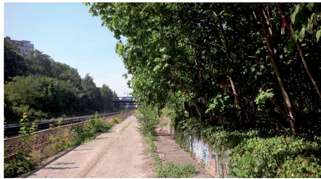
Links die S1, mittig die Baustraße über den Stammbahngleisen, rechts der Crellewald, im Hintergrund die Langenscheidtbrücke
