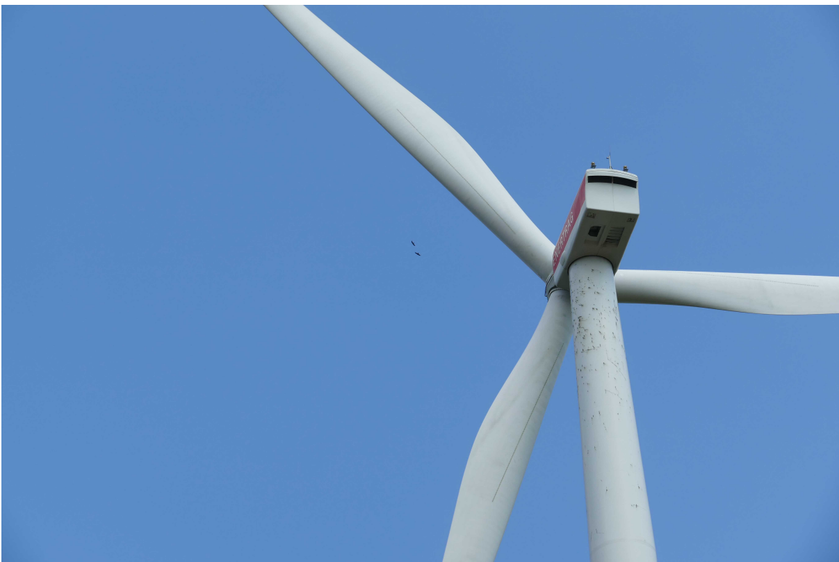
Abbildung 13: Maschinenhaus der Windkraftanlage GE-28130156 mit erkennbaren Verschmutzungen.
