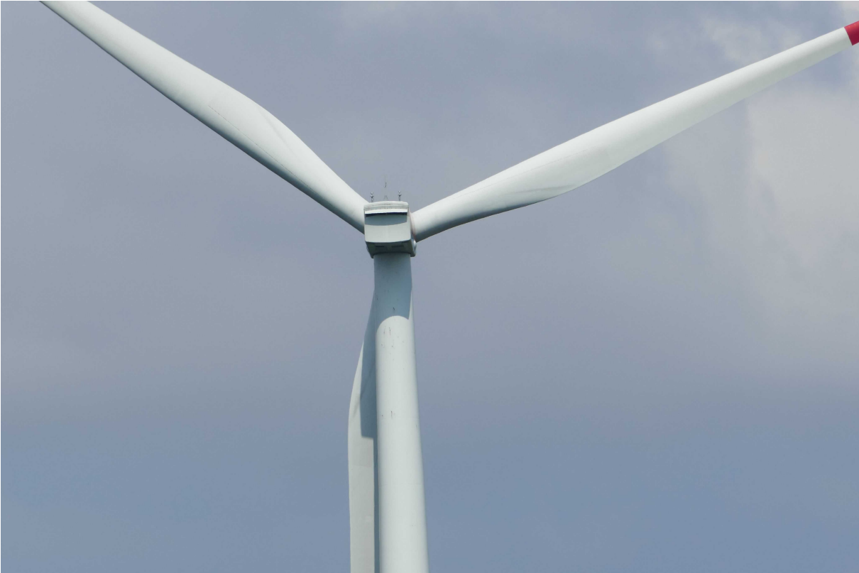
Abbildung 18: Maschinenhaus der Windkraftanlage GE-2813015x mit erkennbaren Verschmutzungen.
