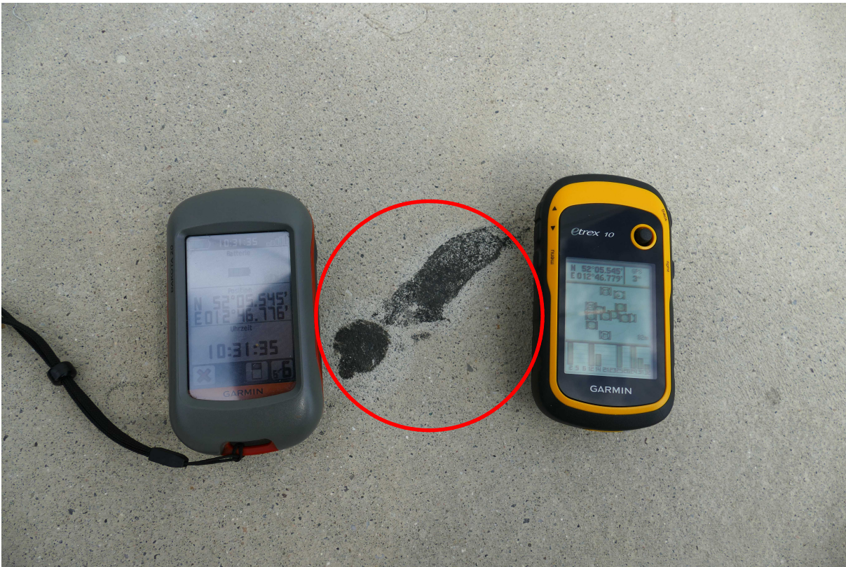
Abbildung 4: Schmierfettfund (rot markiert) an der Windkraftanlage GE-28130154; Aufnahme mit GPS-Koordinaten-Abgleich.
