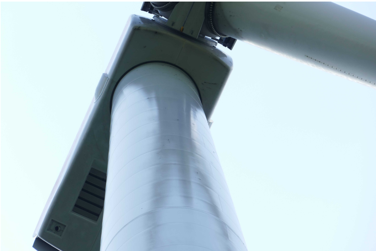
Abbildung 20: Maschinenhaus der Windkraftanlage GE-28150126 mit erkennbaren Verschmutzungen.
