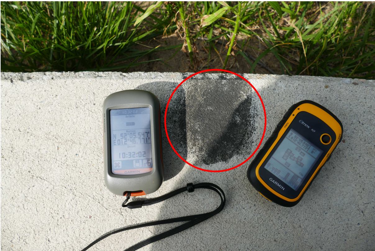
Abbildung 5: Schmierfettfund (rot markiert) an der Windkraftanlage GE-28130154; Aufnahme mit GPS-Koordinaten-Abgleich.
