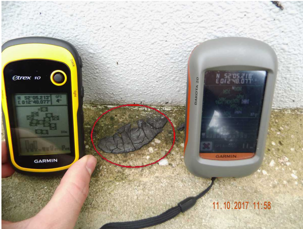
Abbildung 51: Schmierfettfund (rot markiert) an der Windkraftanlage GE-28130158; Aufnahme mit GPS-Koordinaten-Abgleich
