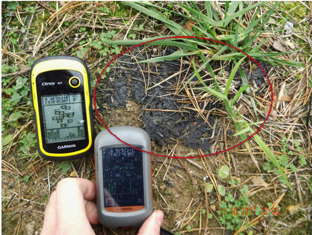
Abbildung 53: Schmierfettfund (rot markiert) an der Windkraftanlage GE-28130158; Aufnahme mit GPS-Koordinaten-Abgleich
