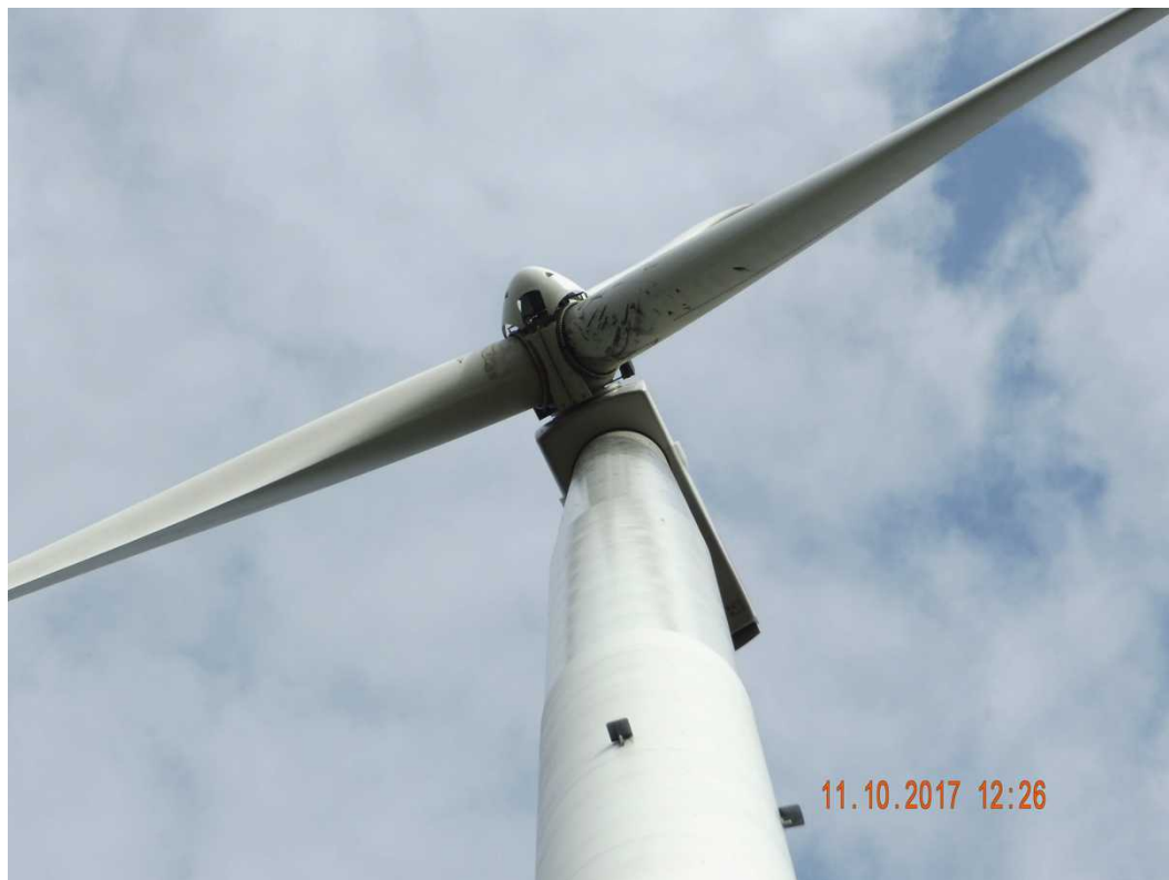
Abbildung 12: Maschinenhaus der Windkraftanlage GE-28130156 mit erkennbaren Verschmutzungen
