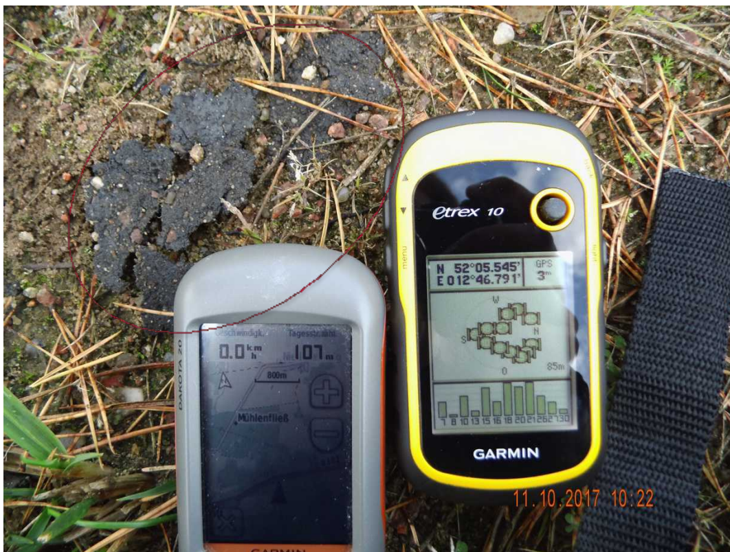
Abbildung 6: Schmierfettfund (rot markiert) an der Windkraftanlage GE-28130154; Aufnahme mit Kartenaufnahme und GPS-Koordinaten
