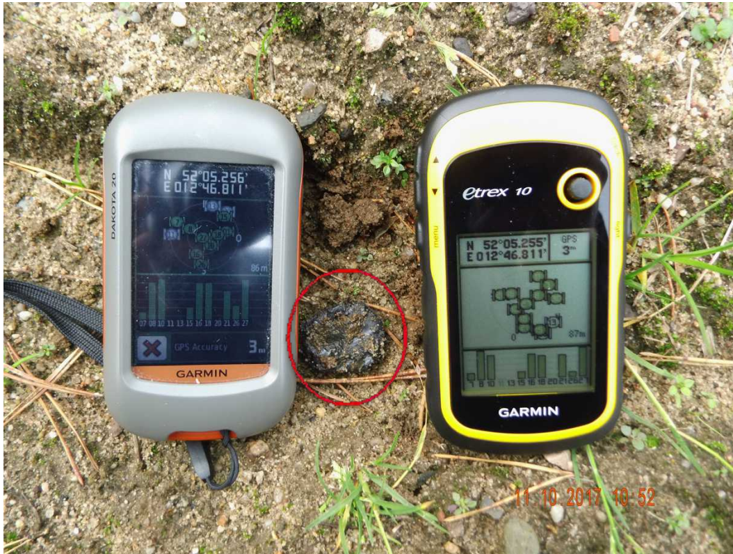
Abbildung 23: Schmierfettfund (rot markiert) an der Windkraftanlage GE-28130157; Aufnahme mit GPS-Koordinaten-Abgleich
