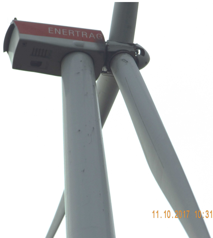
Abbildung 5: Maschinenhaus der Windkraftanlage GE-28130154 mit erkennbaren Verschmutzungen (Foto nachträglich im Kontrast und Helligkeit bearbeitet).
