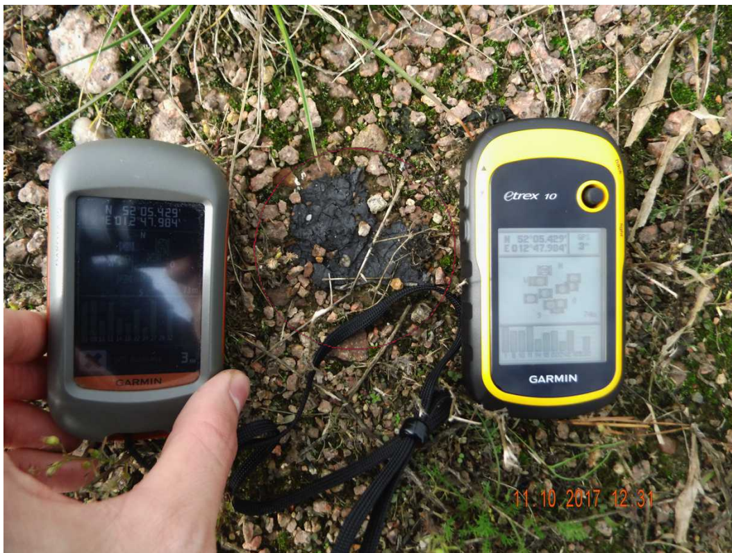
Abbildung 18: Schmierfettfund (rot markiert) an der Windkraftanlage GE-28130156; Aufnahme mit GPS-Koordinaten-Abgleich
