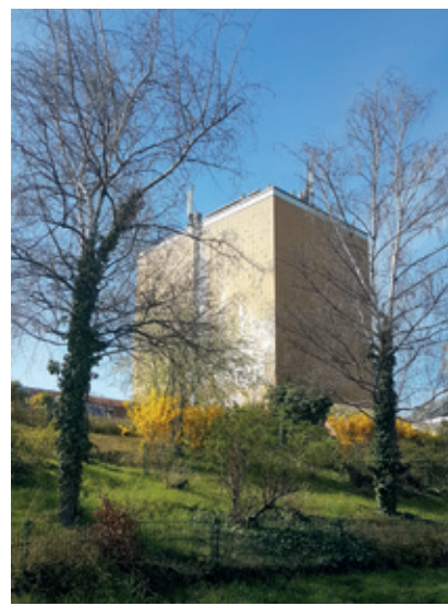
Hanglage am Autobahntunnelportal
