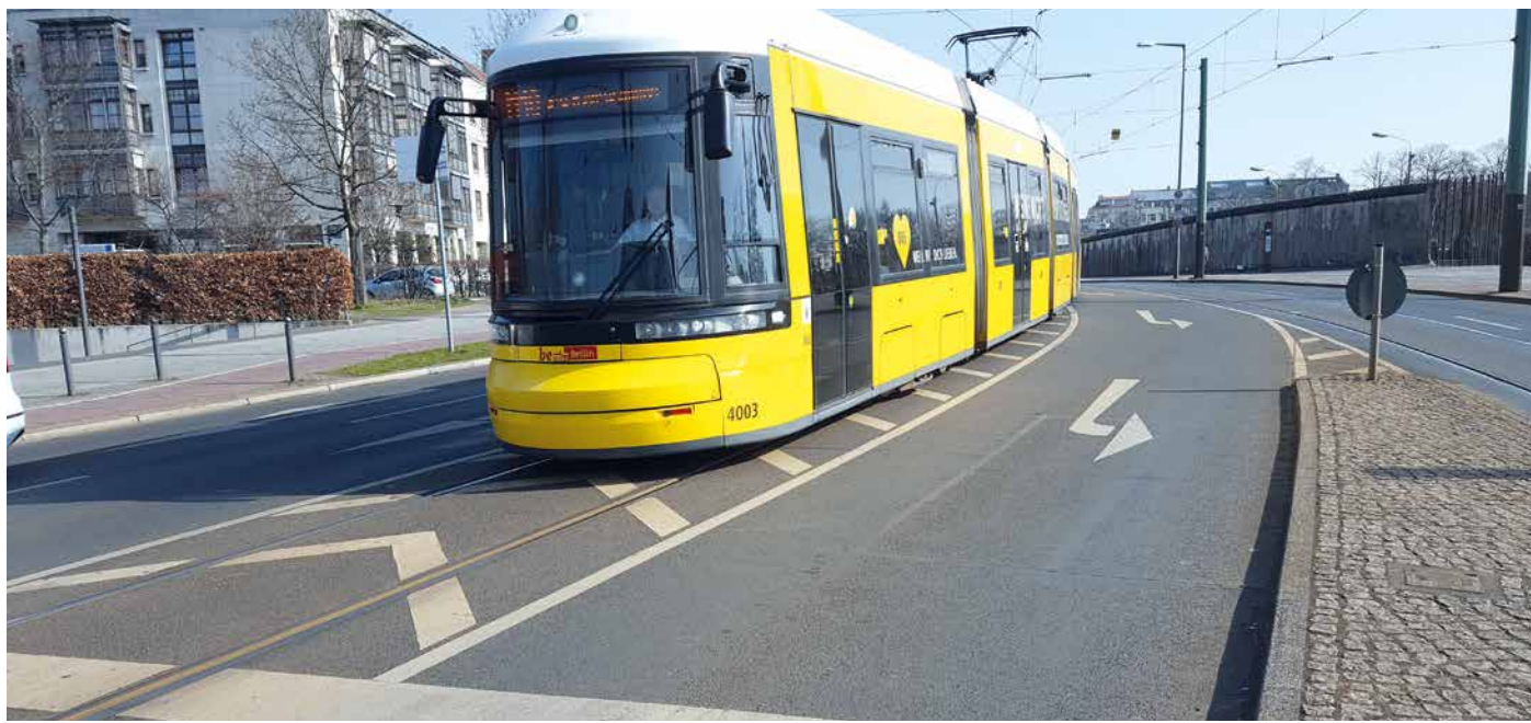
Schlechtes Vorbild Bernauer Straße: Tram ohne eigene Trasse
